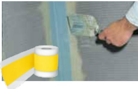
Preko "dihtujuće trake" (Murexin DB 70) izravnjavate površinu špahtl-masom. Podloga postaje idealno glatka i njena priprema je završena!
