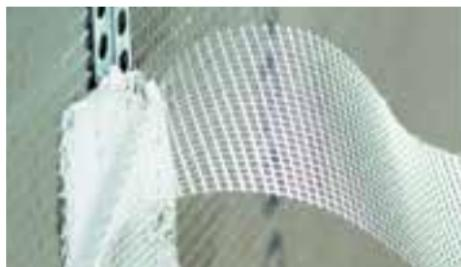
Staklenom tekstilnom mrežicom "zatvarate" spoj dve ploče.
