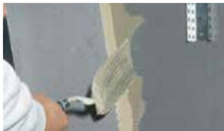
Odmah zatim postavljate ploču **Austrotherm UNIPLATTE®** u ležišta spojnica i na taj način biva odmah fiksirana. Prav ugao ( $90^\circ$ ) je zahvaljujući spojnici zagarantovan.
