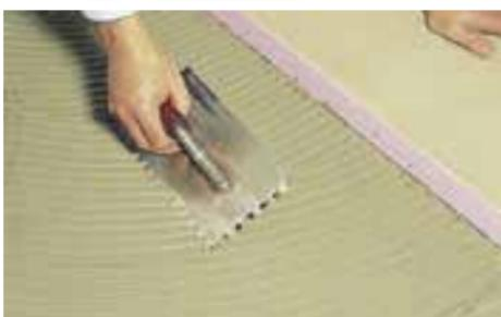
Lepak perfektno prijanja - bez obzira da li je podloga estrih ("košuljica") ili beton. Ukoliko podloga nije noseća, onda se **Austrotherm UNIPLATTE®** mora tiplovima pričvrstiti za nju.
