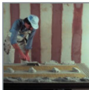
Kod izolacionih ploča MF s kaširanom tvrdom mineralnom vunom potrebno je pre lepljenja na poleđinu ploče, po sredini i po rubovima, naneti i utisnuti tanak sloj Perlfix-a u širini od cca. 10 cm.
