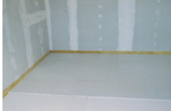
**Suvi estrih F 146:** Prvo je potrebno uz zidove postaviti i učvrstiti odvojne trake od mineralnih vlakana debeline 10 mm. Na ravnom i glatkom betonskom podu postavlja se građevinska PE folija (debljine 0,2 mm) i podiže uz zidove. Kod drvenih meduspratnih konstrukcija koristi se valoviti karton umesto PE folije.
