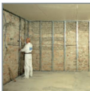
Nakon ugradnje instalacija i postavljanja izolacije, Knauf ploče se u vertikalnom položaju učvršćuju za potkonstrukciju samoureznim TN vijcima. Razmak vijaka je maks. 25 cm. Po potrebi se između ploče i profila ugrađuje parna brana.
