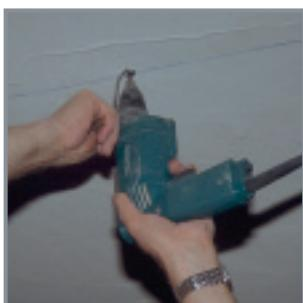
Visinu spuštanja (visinu plafona) treba označiti na zidovima i UD-profile odgovarajućim tiplovima i vijcima učvrstiti na razmaku od oko 50 cm za zid. Na nosećem plafonu označiti mesta vešanja i montirati žice sa ušicama za plafon.
