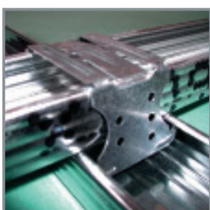
Zatim se krstastom spojnicom montažni profili (CD- profili) pravougaono povezuju sa obešenom nosećom konstrukcijom. Krstasta spojница se iznad nosećeg CD- profila savije i utakne u donji montažni CD- profil.
