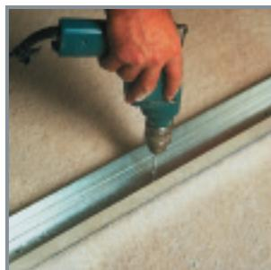
Na sredini visine zida se učvršćuju akustični ili direktni vezači za prihvati vertikalnih CD profila (maks. međusobni razmak vezača je 1,50 m) s nalepljenom dihtung trakom.
