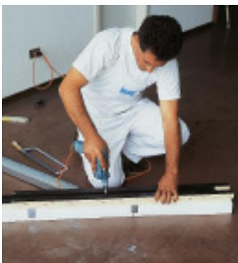
Poprečni nosač i aluminijumska vodica se skraćuju prema potrebnoj širini krila vrata odnosno svetlog otvora. Aluminijumsku vodicu potrebno je vijcima učvrstiti za poprečni nosač.
