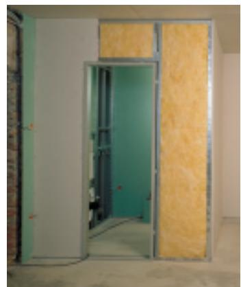
*Vertikalni spojevi ploča ne smeju biti u nastavku profila*
