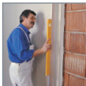
Zalepljenu ploču pomoću letve i gumenog čekića postaviti u vertikalni položaj i u odgovarajući ravan. Otvoreno vreme za postavljanje u završni položaj je maks. 10 min. nakon nanošenja lepka Knauf Perlfix. Nakon toga se istim postupkom postavlja sledeća ploča do prethodno postavljene. Uzdužni spojevi ploča se moraju dodirivati a sve ploče moraju biti međusobno poravnate u istoj ravni.
