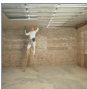
Knauf ploče debljine 12,5 mm se učvršćuju samouredujućim vijcima TN 25 za montažne profile, uzdužne ivice ploča usmerene su poprečno prema smeru postavljanja profila potkonstrukcije. Kod montaže spojevi ploča se moraju dodirivati i moraju biti obrađeni. Ploče se ne učvršćuju vijcima za obimne UD-profile.
