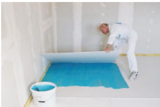
Zatim gipsanim Knauf lepkom nalepiti drugi sloj uz pomak za polovinu ploče. Ploče uz pritisak telesne težine učvrstiti čeličnim klamericama za prvi sloj.
