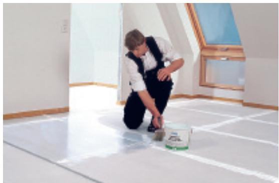
Suvi estrih nakon polaganja ne opterećivati oko 10 h kako bi se lepak potpuno osušio. Otvorene spojeve ispuniti Knauf Uniflott-om. Pre polaganja završnih podnih podloga podnu površinu premazati Knauf Estrichgrundom. Na taj način se reguliše moć upijanja po čitavoj površini i poboljšava se privlačljivost obloge.
