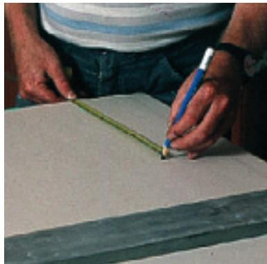
A - označiti crtu rezanja ploče
