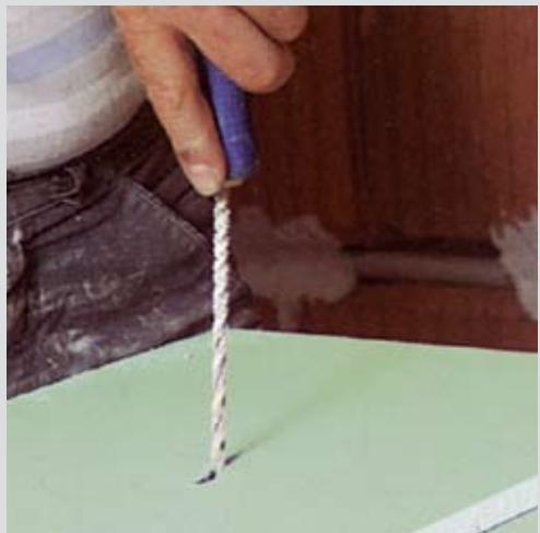
Otvori za elektrokućije isecaju se ubodnom turpijom ili bušilicom na koju se montira krunsa testera odgovarajućeg prečnika.
