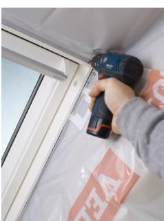
Postavlja se između gipsa i termoizolacije, u kosini potkrovlja, sprečavajući vlagu koju gipsana ploča može da akumulira da dođe do vune.
