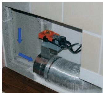
Primer: dovod vazduha za sagorevanje iz Termo kanala do kaljeve peći (automatski dovod)
