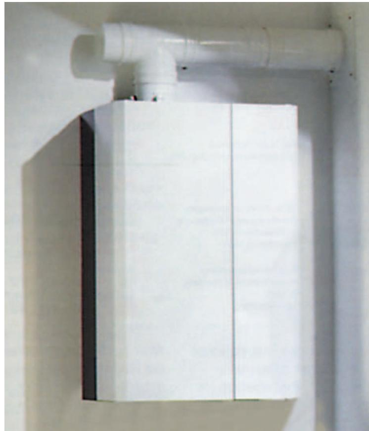
Kod ove vrste kotlova iza ložišta ugrađen je dodatni toplotni izmenjivač koji koristi toplotu vodene pare. Kod Schiedel Absolut dimnjaka, prečnika 14 cm, možemo koristiti princip protivstrujnog delovanja i dovodimo vazduh za sagorevanje koji se nalazi između cevi dimnjaka i kanala sa izolacijom. Korišćenjem toplote gasova sagorevanja za predgrejanje vazduha za sagorevanje iskorišćenost grejnog uređaja se dodatno poboljšava.
