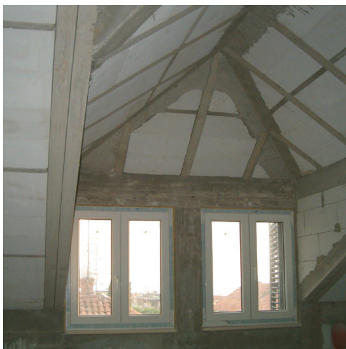
DETALJ KROVNE BADŽE
