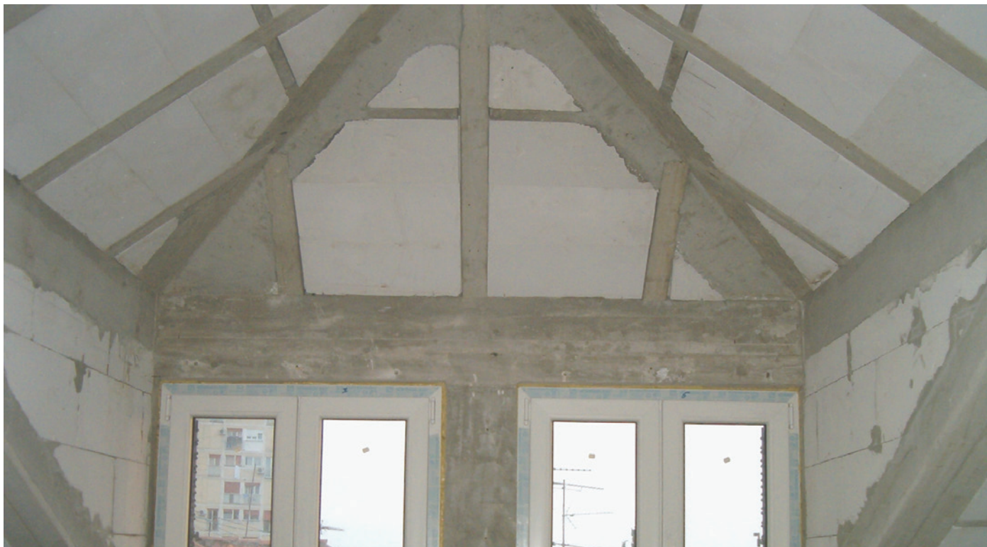
DETALJ KROVNE BADŽE
